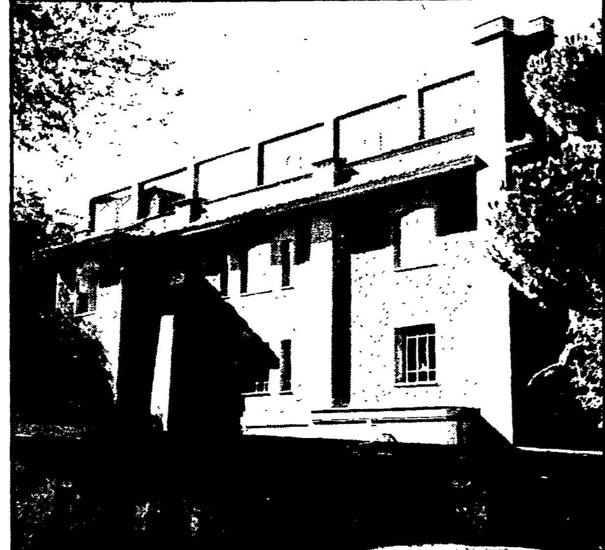
L'edificio del «Tata Giovanni»
