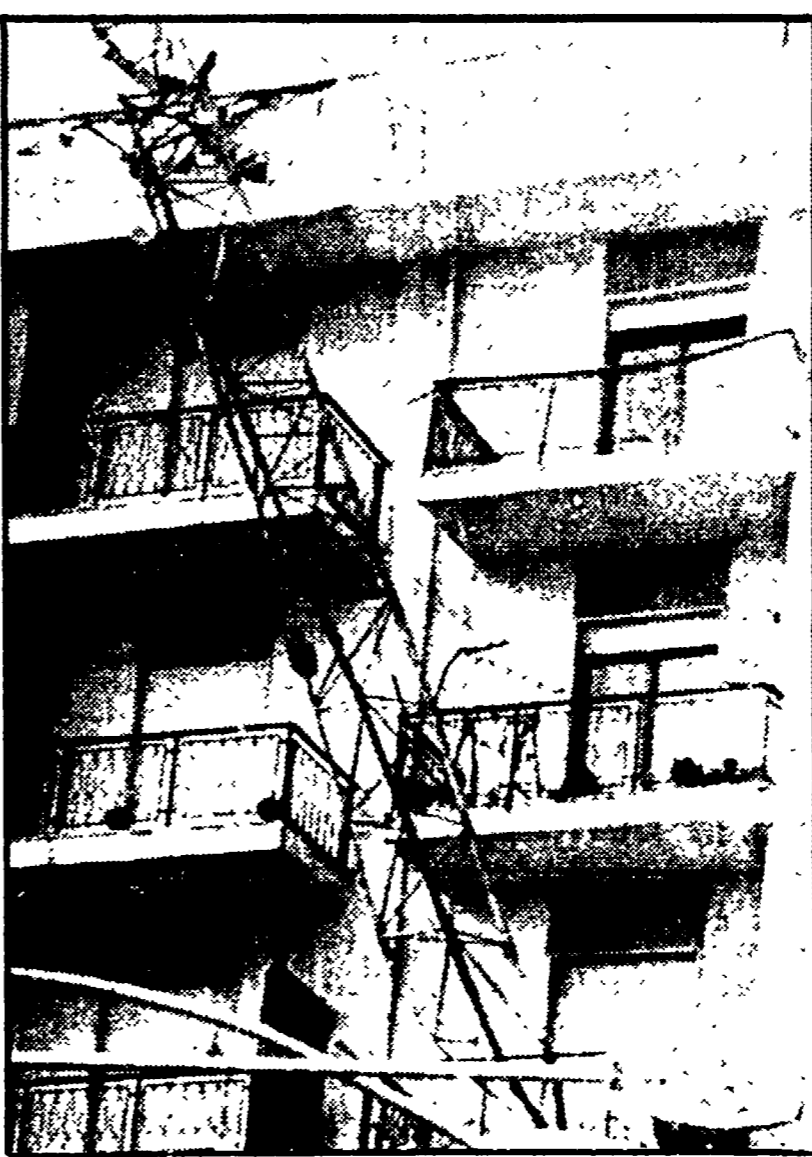
CATANZARO - Il braccio di una gru scaraventato dalla tromba d'aria contro le finestre di un edificio
