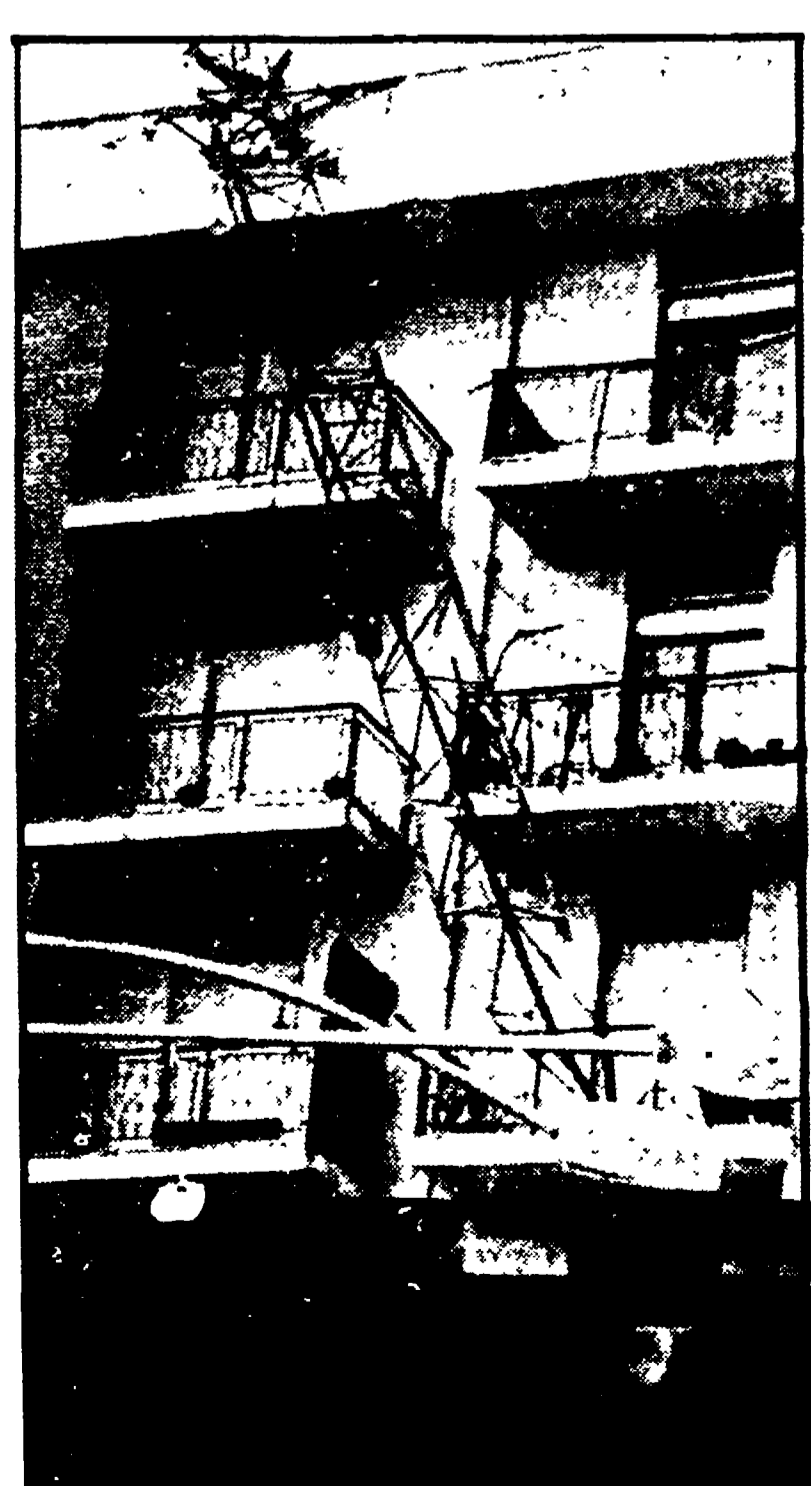
Un palazzo di Calanzaro Lido. La tromba d'aria ha sbattuto contro la sua facciata una pesante gru di un vicino cantiere
