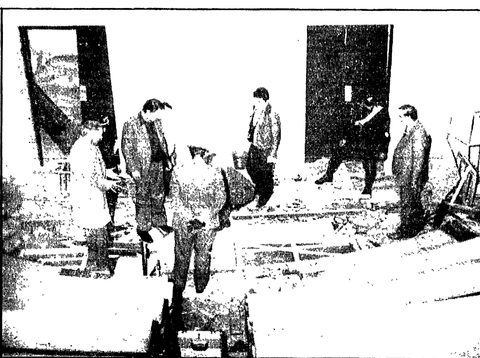
L'aula di anatomia patologica gravemente danneggiata dall'esplosione
