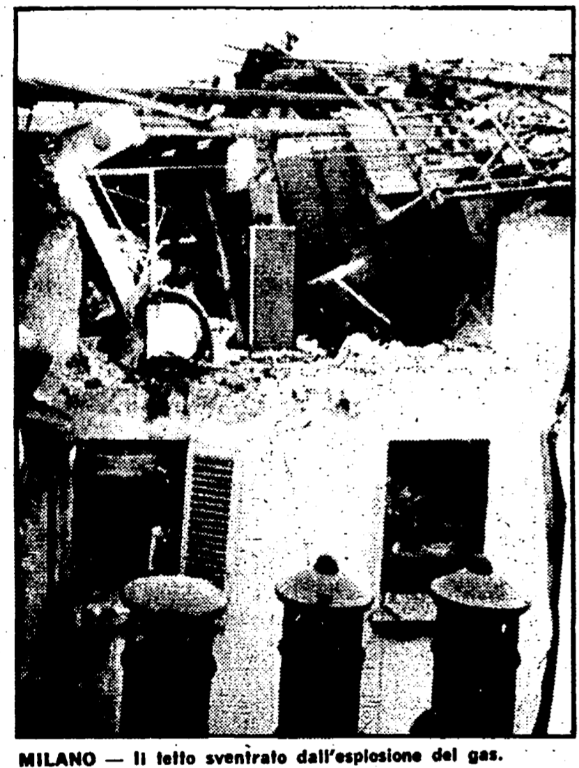
MILANO - Il tetto sventrato dall'esplosione del gas.
