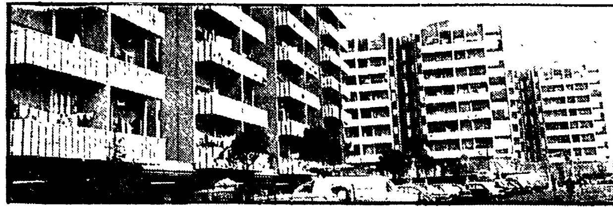
Le palazzine di Caltagirone a Casalbruciato: sono già in rovina dopo pochi anni. E il costruttore pretendeva anche i soldi.
