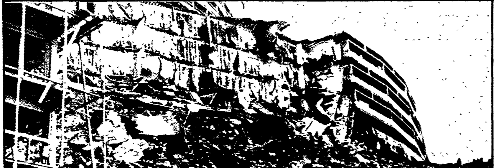
Un'alza di un palazzo franato in seguito ad una alluvione
