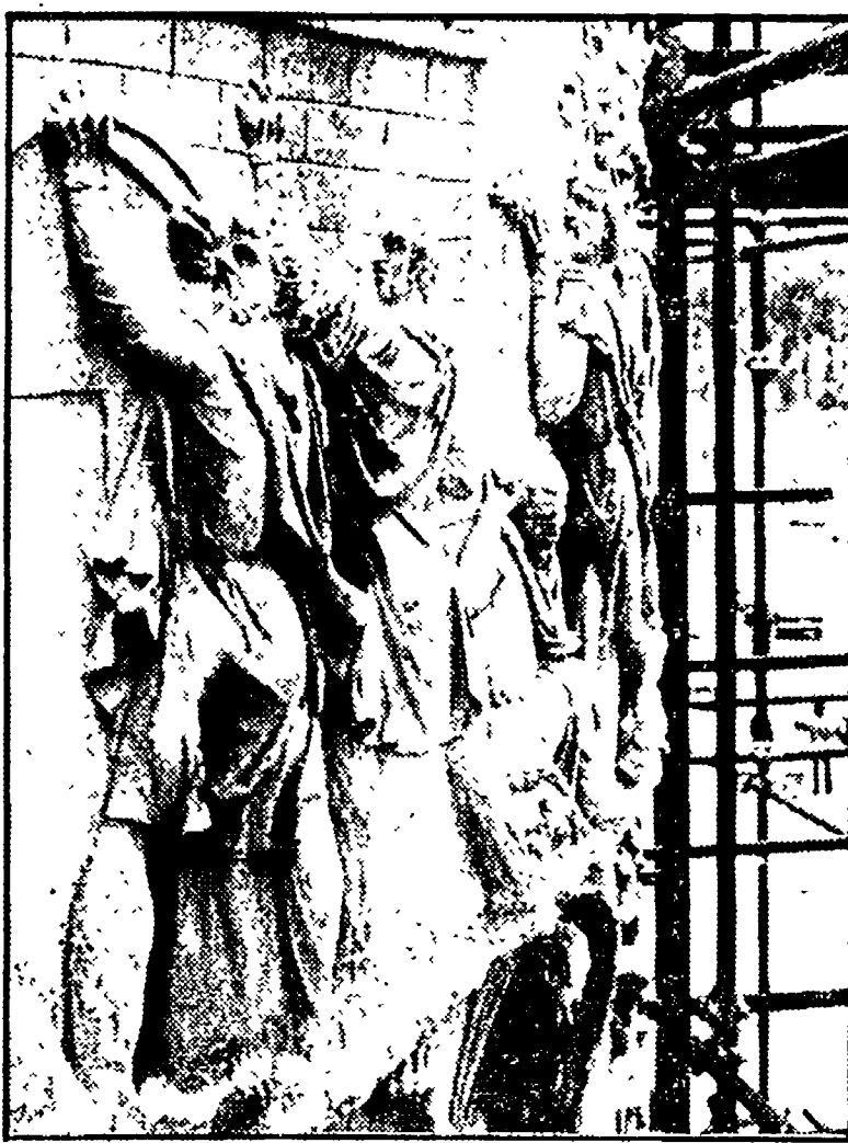
ROMA — Un particolare della Colonna Traiana ormai circondata dai ponteggi
