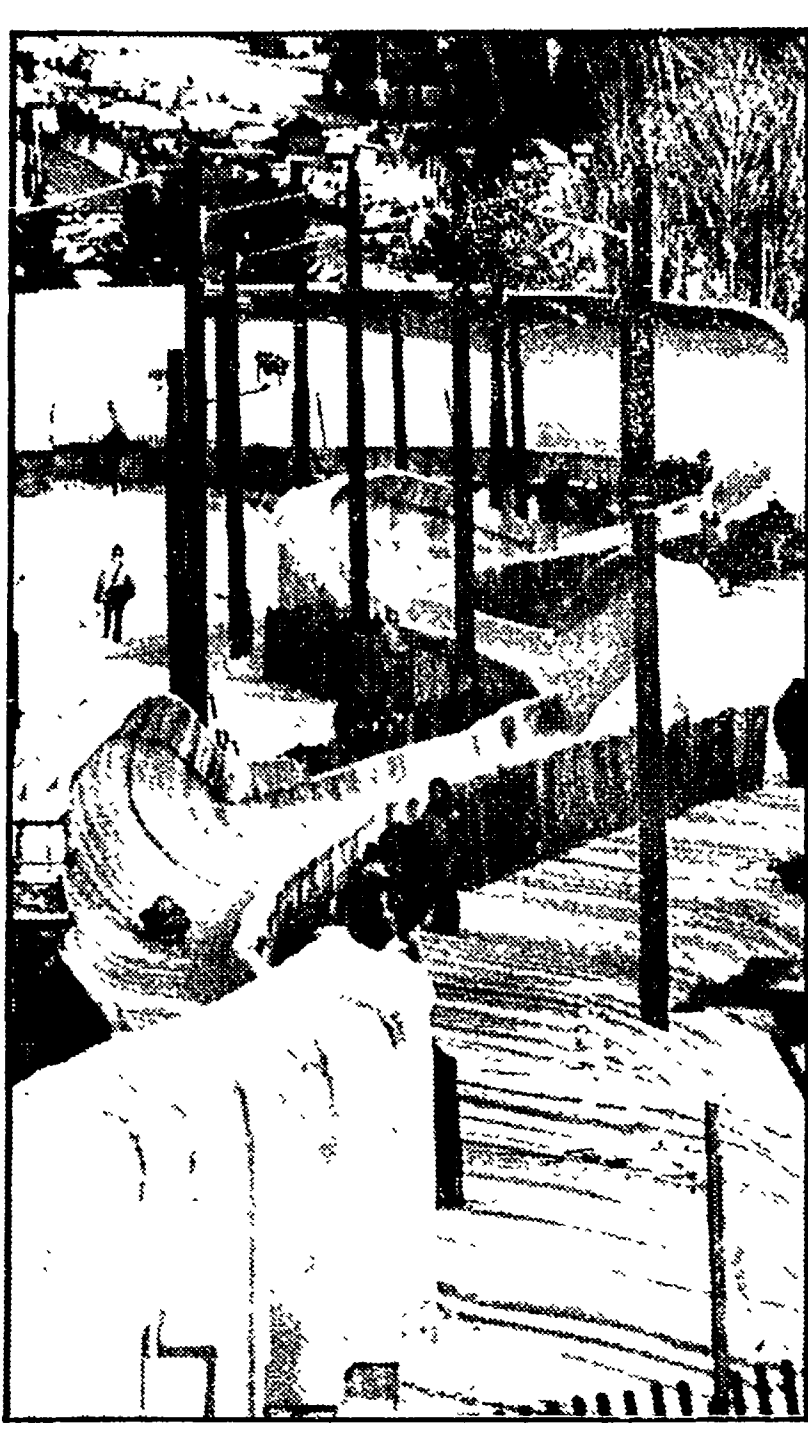
LAKE PLACID - Uno scorcio della pista per le gare olimpiche di bob. Il percorso si presenta molto pericoloso
