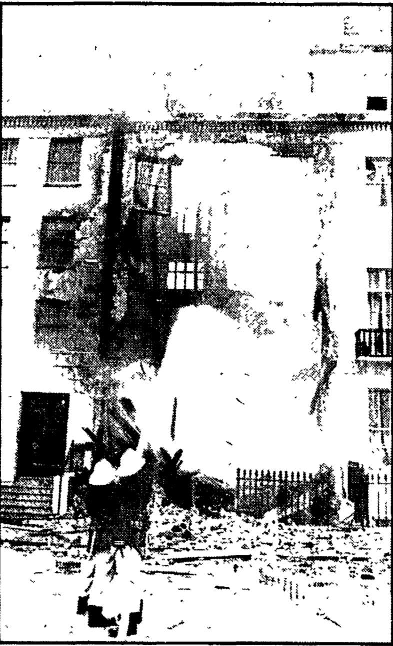
LONDRA - Dove una volta c'era il consolato italiano resta solo il vuoto. La foto mostra in tutta la loro drammaticità gli effetti devastanti dell'esplosione e dell'incendio
