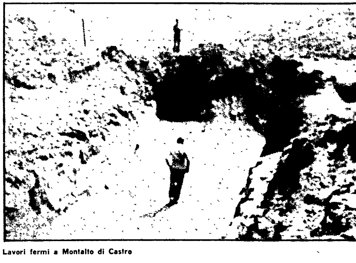
Lavori fermi a Montalto di Castro
