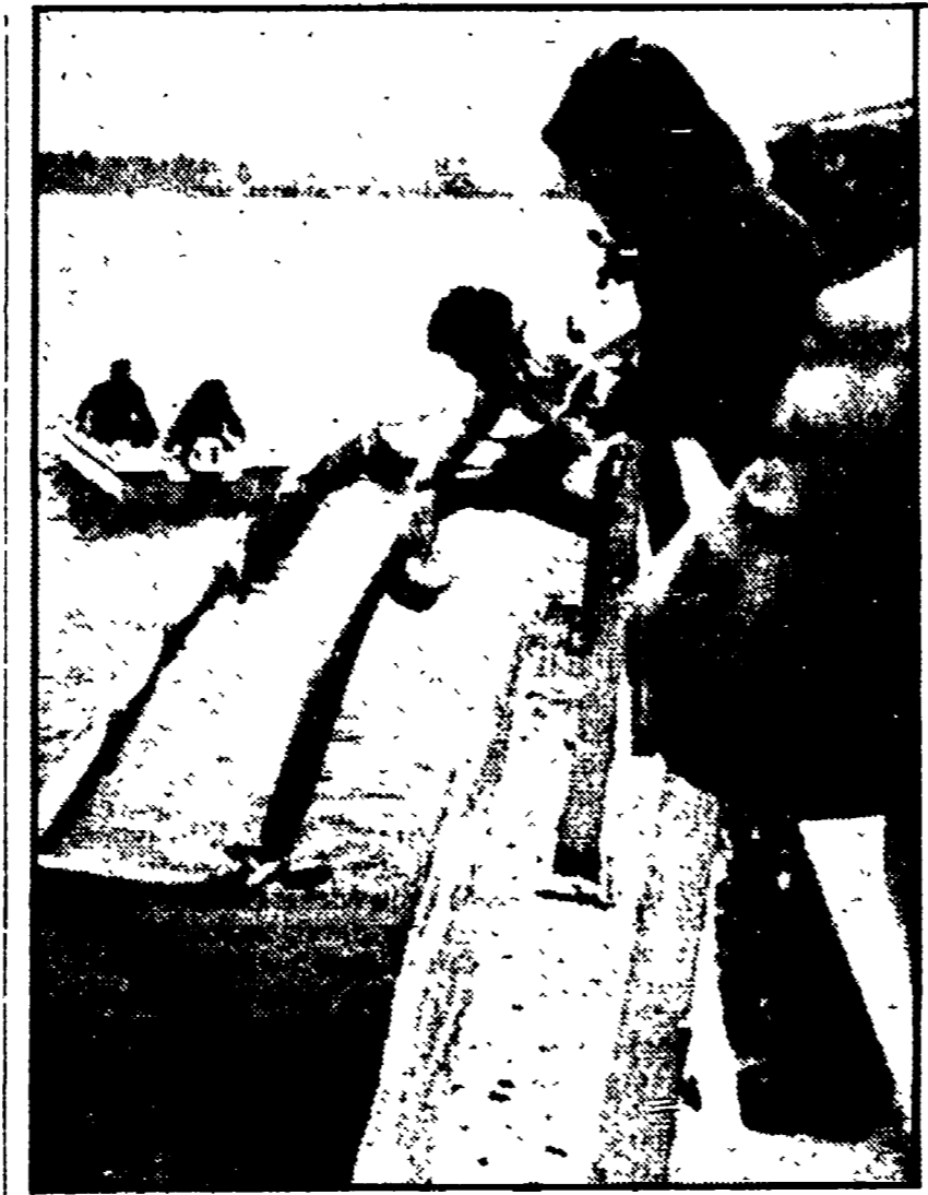
PIACENZA — Tecnici mentre preparano uno sbarramento alla diga dell'ENEL
