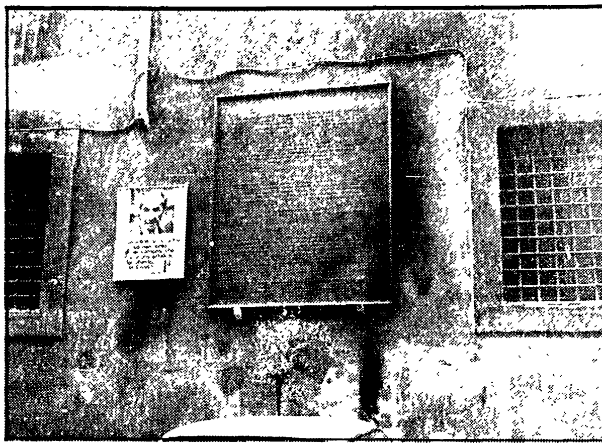
La lapide in ricordo di Aldo Moro annerita dopo l'incendio della corona d'alloro
