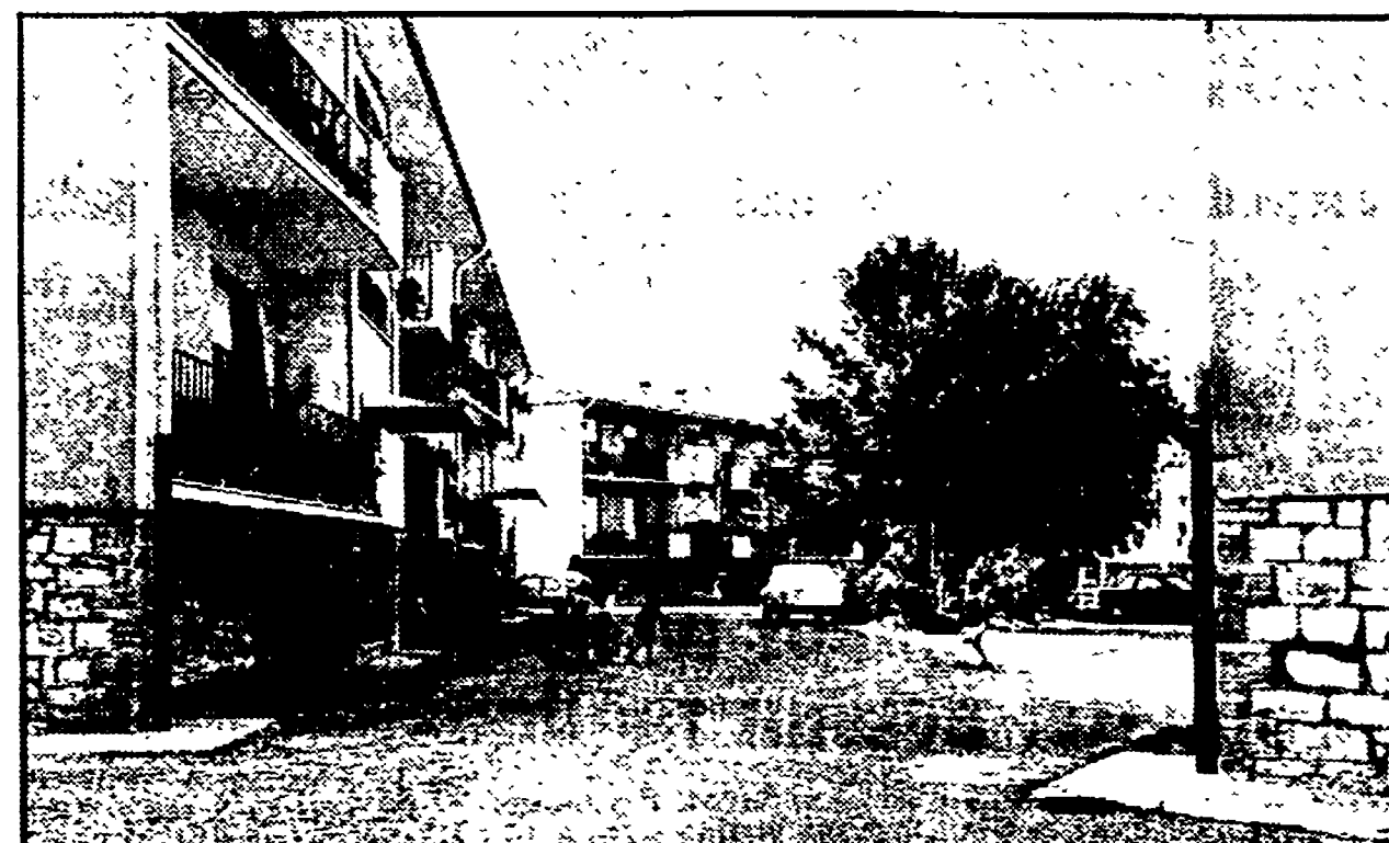
Uno scorcio del quartiere Metelli dove verrà realizzata un'area di verde attrezzato
