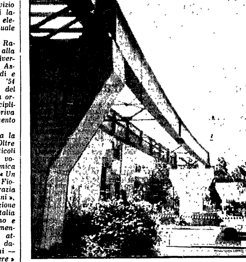
Il ponte all'indiano continua a crescere: ieri mattina gli operai hanno sistemate le travi per far proseguire lo svincolo dalla parte di via Baracca, all'altezza delle vecchie case demolite
