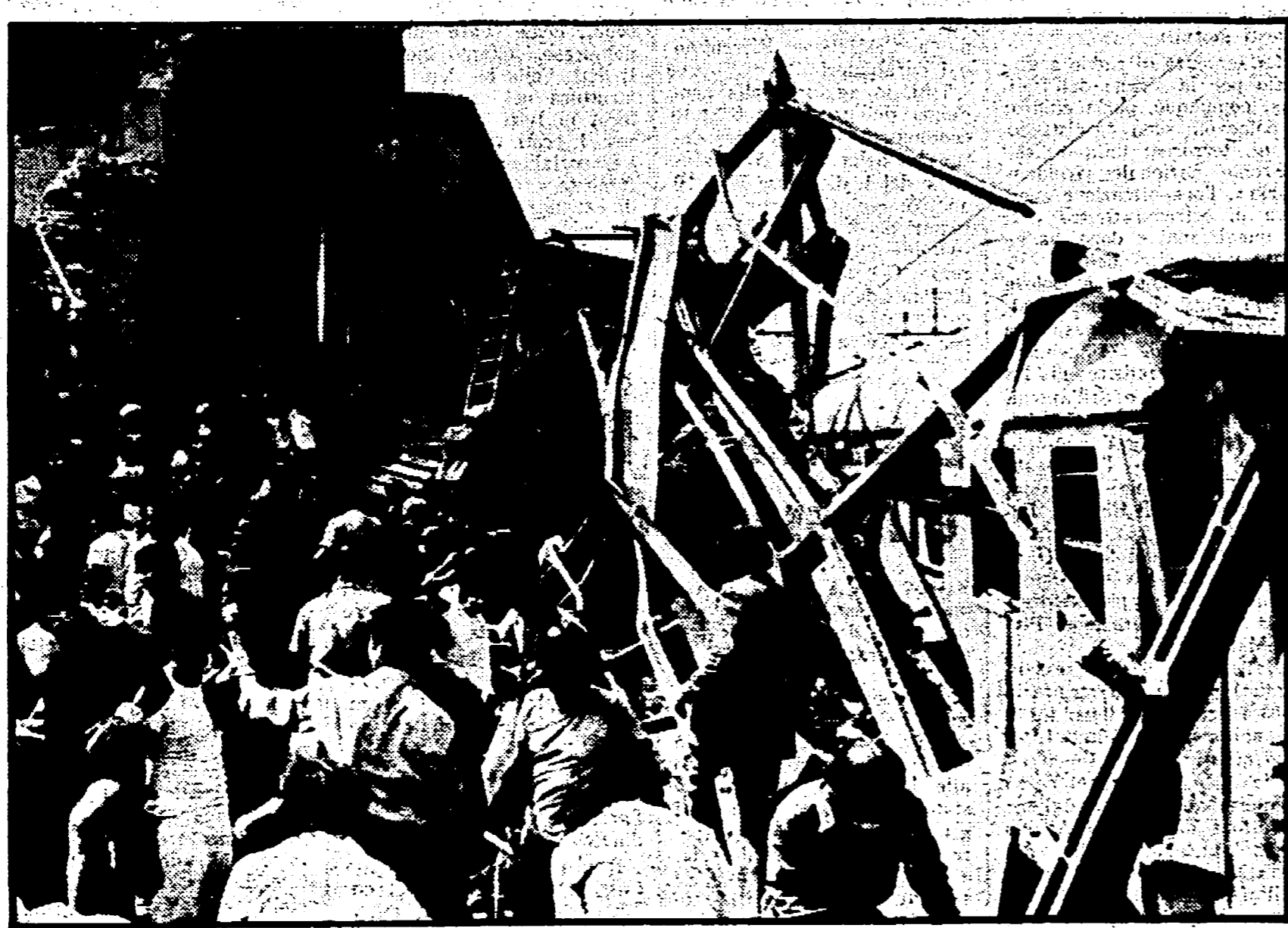
BOLOGNA - Il lavoro dei soccorritori tra le macerie della pensilina del primo binario
