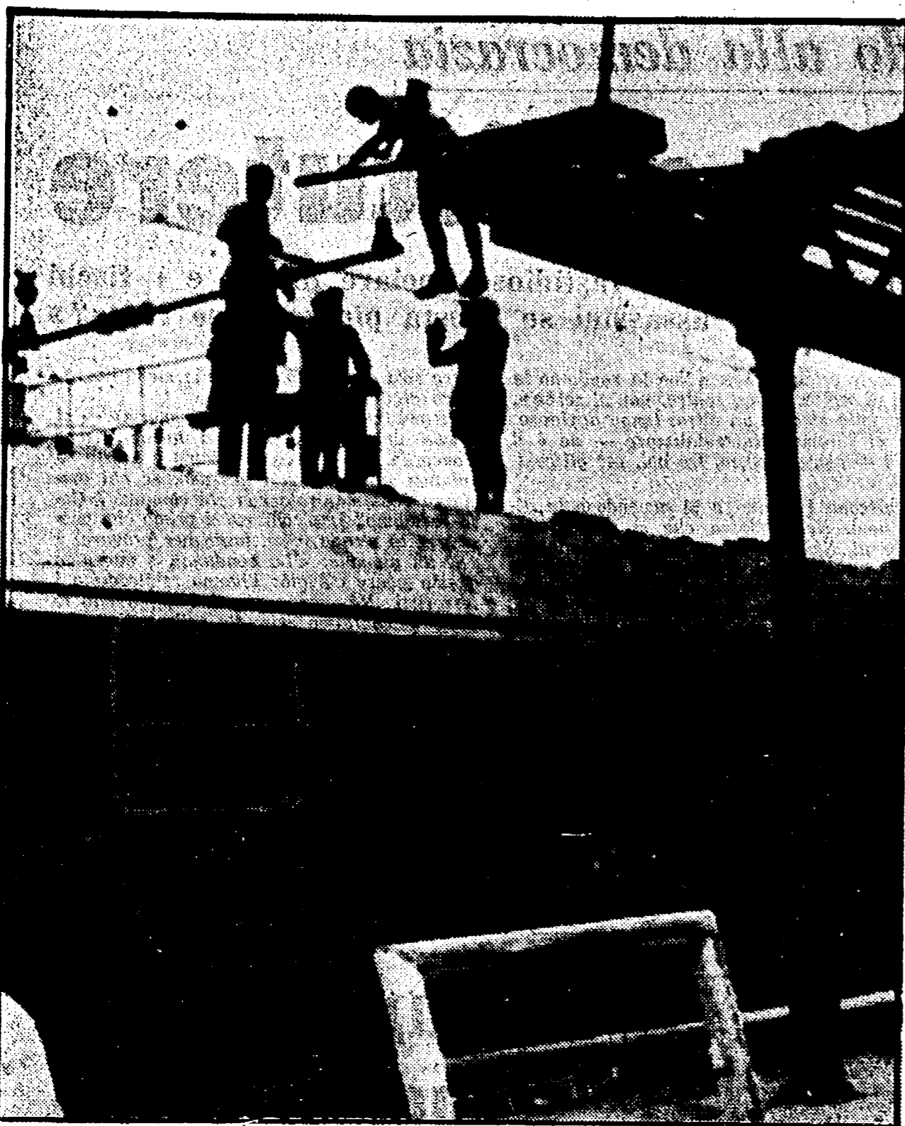
BOLOGNA — Si riparano le linee elettriche sui binari colpiti dall'esplosione
