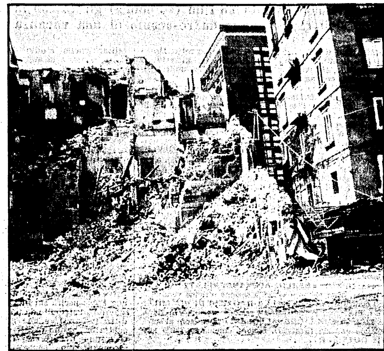
Le macerie del palazzo abbattuto in via Marina
