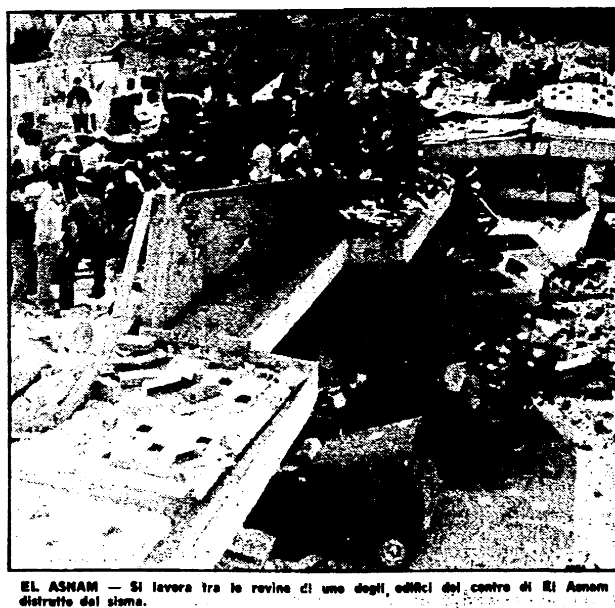
EL ASNAM — Si lavora tra le rovine di uno degli edifici del centro di El Asnam distrutto dal sisma.
