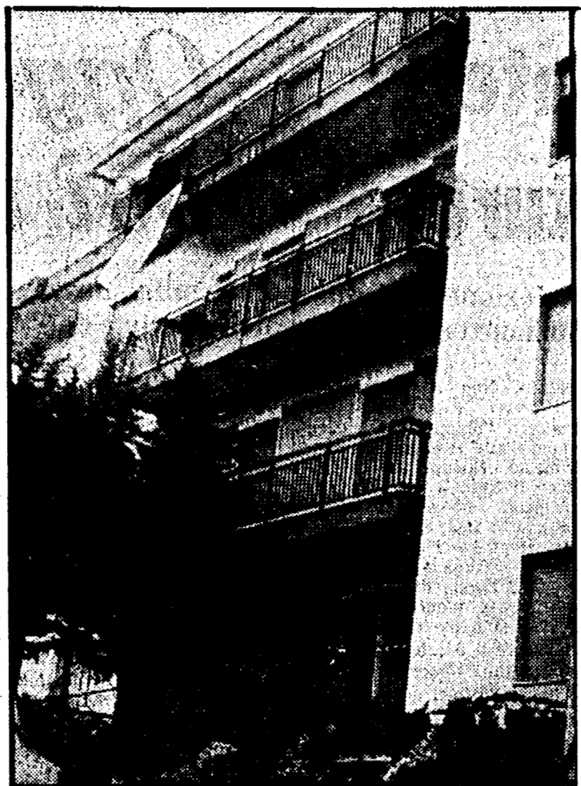
SORRENTO — L'appartamento (indicato dalla freccia) dove è stato rinvenuto il covo dei terroristi
