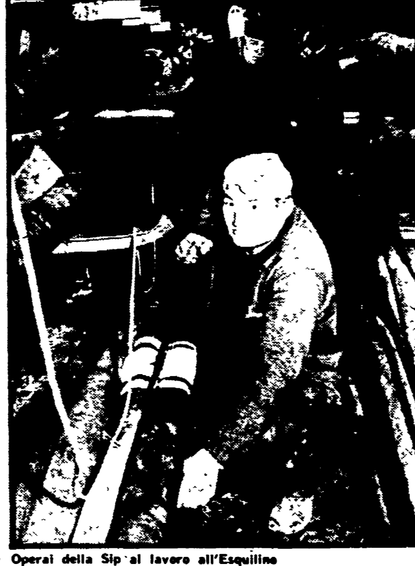
Operai della Sip al lavoro all'Esquilino
