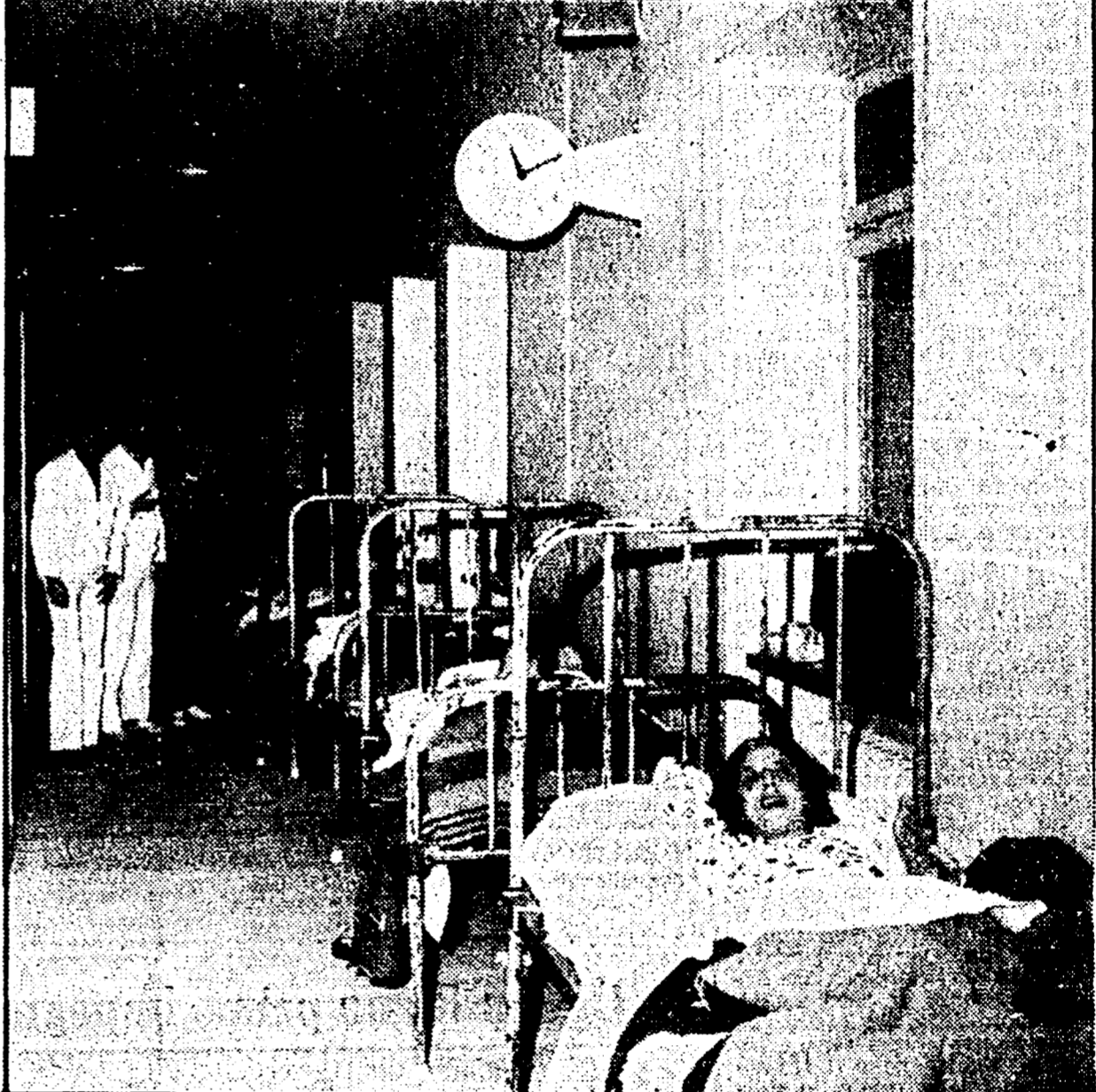
Mentre il sovraffollamento delle corsie resta una delle piaghe più angosciose della situazione sanitaria, si verificano episodi come quello di Noto, dove da ventisei anni è in costruzione un nosocomio che ancora deve vedere la luce
