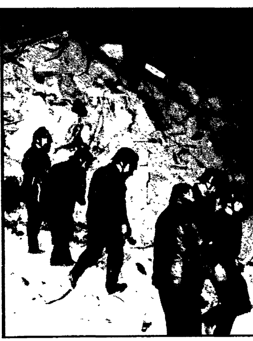
NAPOLI — Il palazzo crollato in via Stadera.
