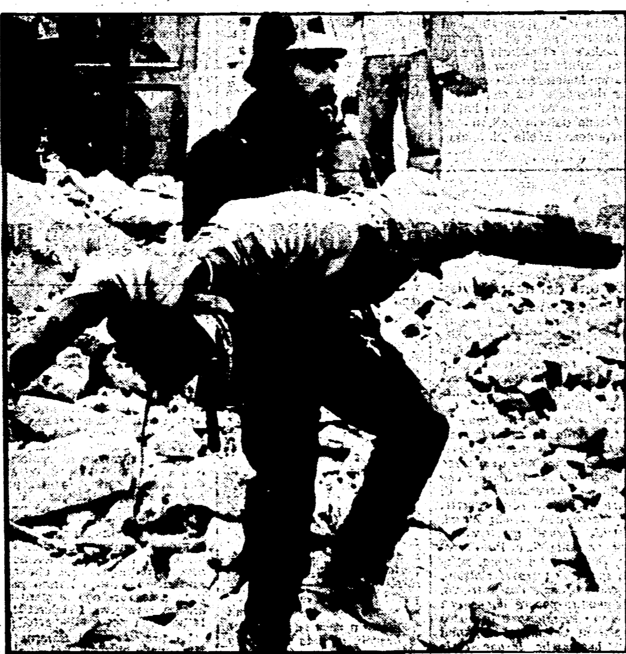
BALVANO — Un vigile del fuoco cerca i resti di un edificio semidistrutto con il corpo di un bambino di 9 anni
