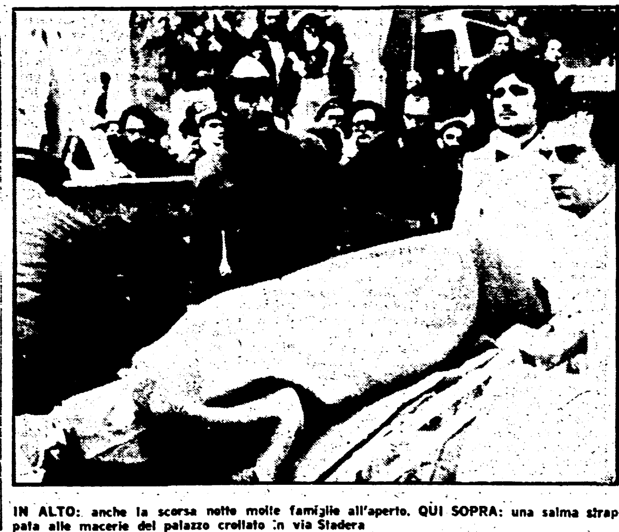
IN ALTO: anche la scorsa notte molte famiglie all'aperto. QUI SOPRA: una salma strapata alle macerie del palazzo crollato in via Stadera
