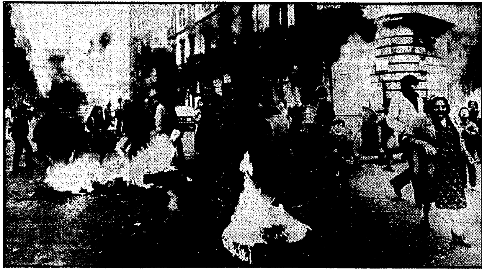
NAPOLI - Abitanti delle strade adiacenti all'Albergo dei Poveri crollato, protestano per sollecitare le perizie tecniche
