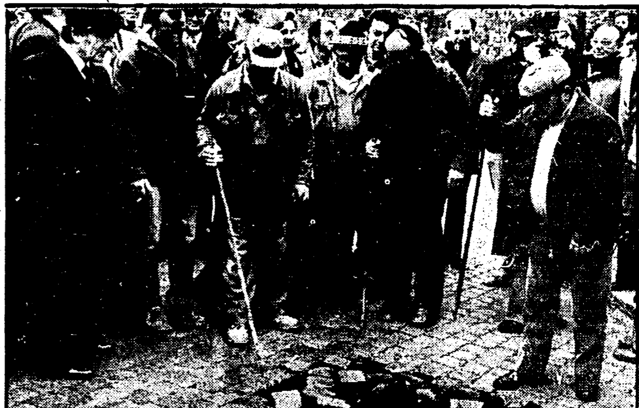
NELLA FOTO: l'inizio dei lavori in via della Consolazione
