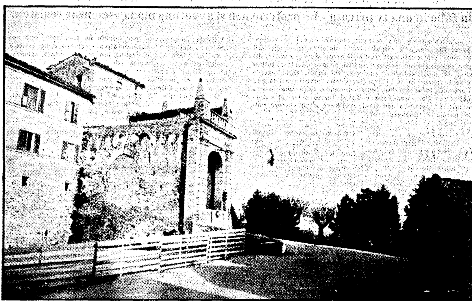
Una zona di rispetto creata con fransenne a Montelupone
