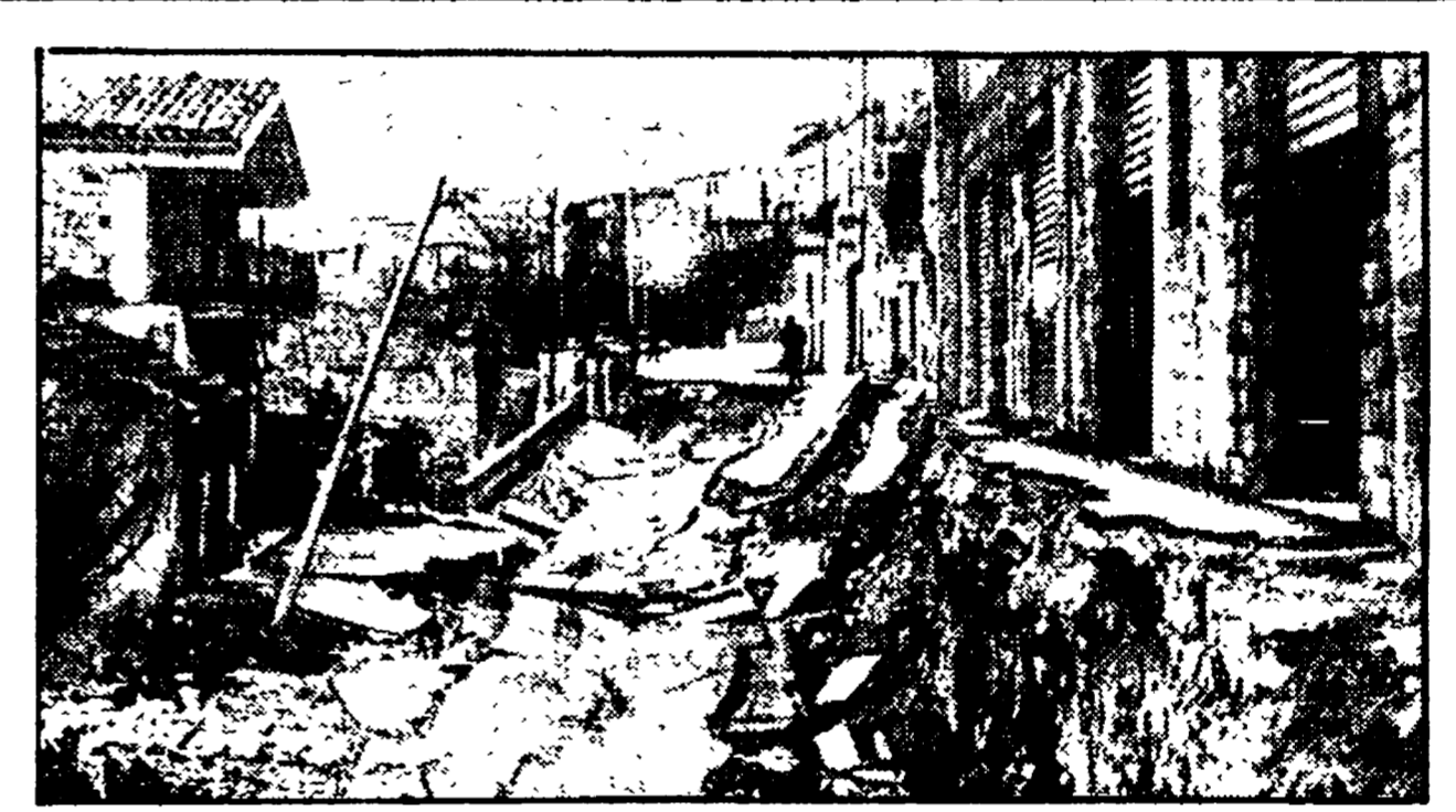
Una strada di Calitri completamente franata
