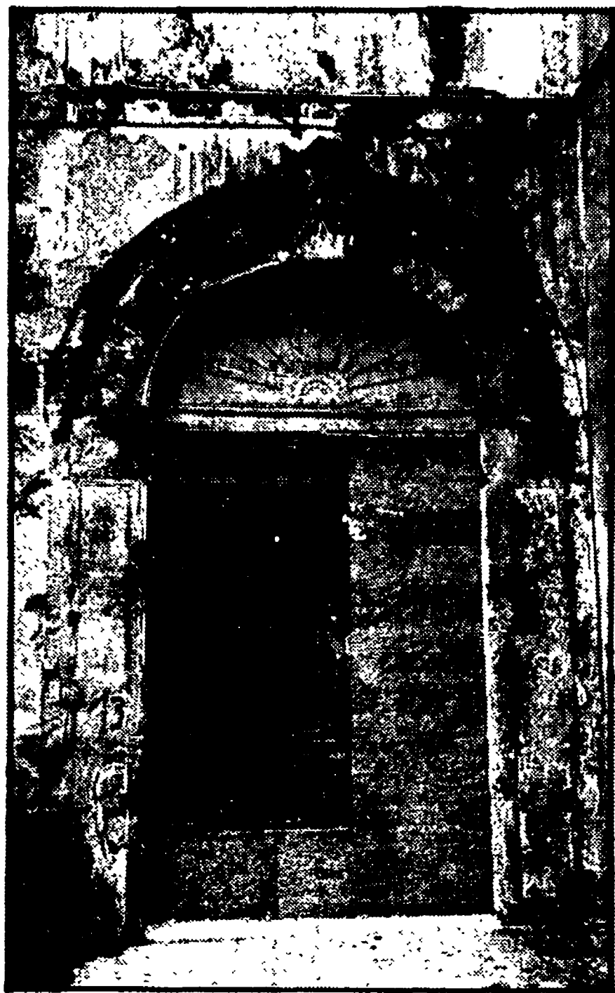
Il portone murato di un edificio pericolante
