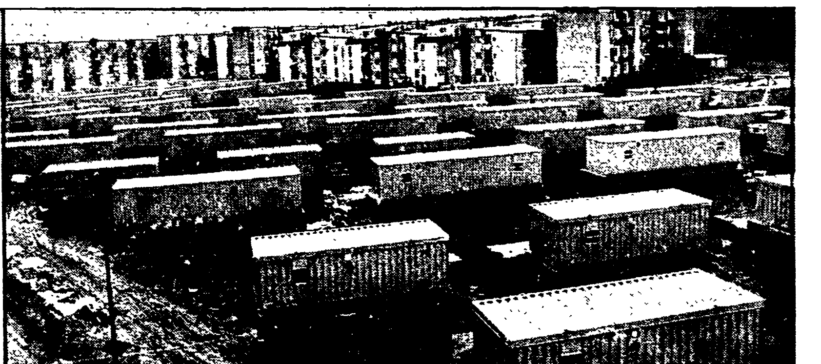
Un gruppo di containers per i terremotati
