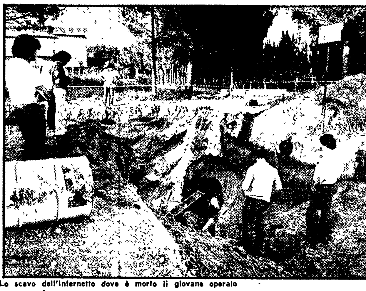
Lo scavo dell'Infernello dove è morto il giovane operaio
