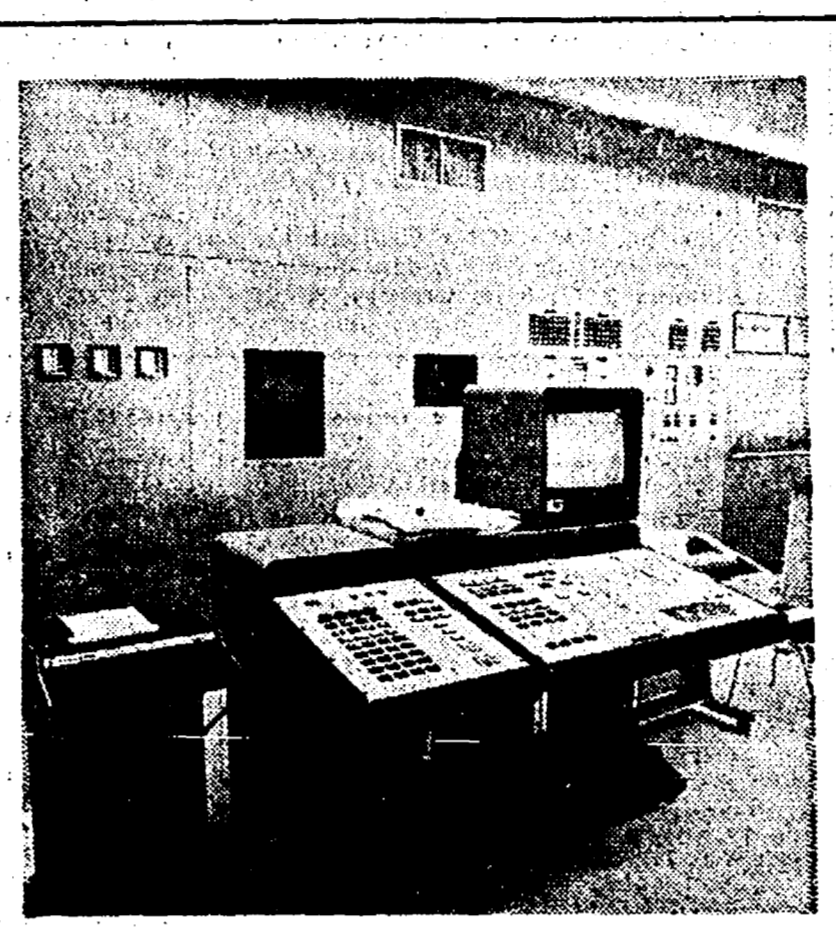
Sala operativa della centrale di Adrano
