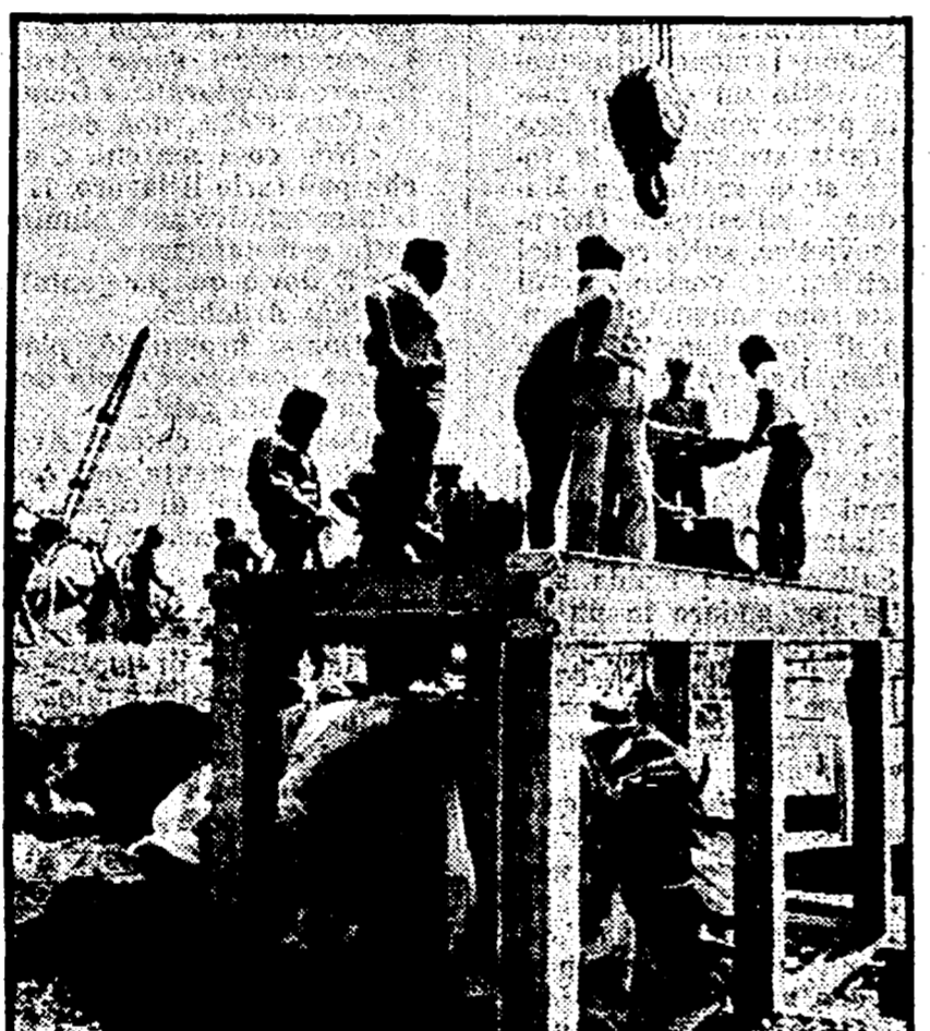
ROMA — La struttura metallica che copre il pozzo dove a sessanta metri si trova il corpo del piccolo Alfredo
