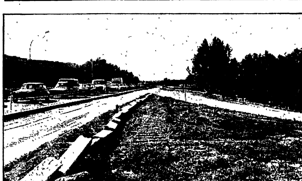
I lavori per Olimpica-Salaria
