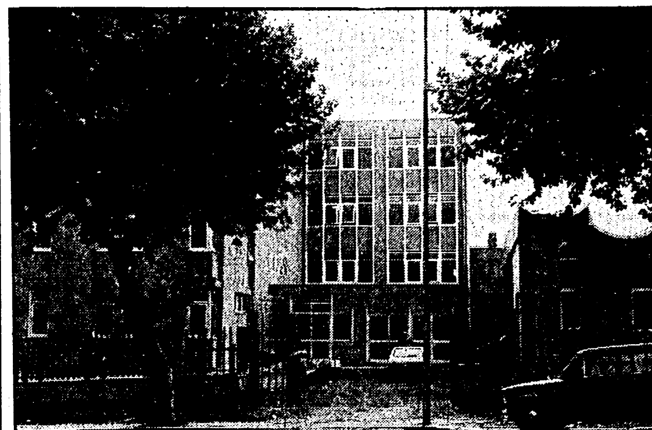
La nuova sede dell'istituto tecnico industriale di Nettuno, inaugurata ieri dall'assessore Ciuffini
