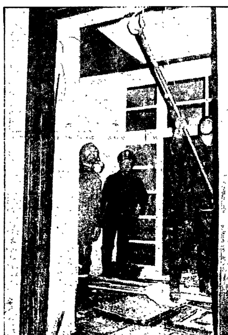
Bomba contro uffici USA a Prati
