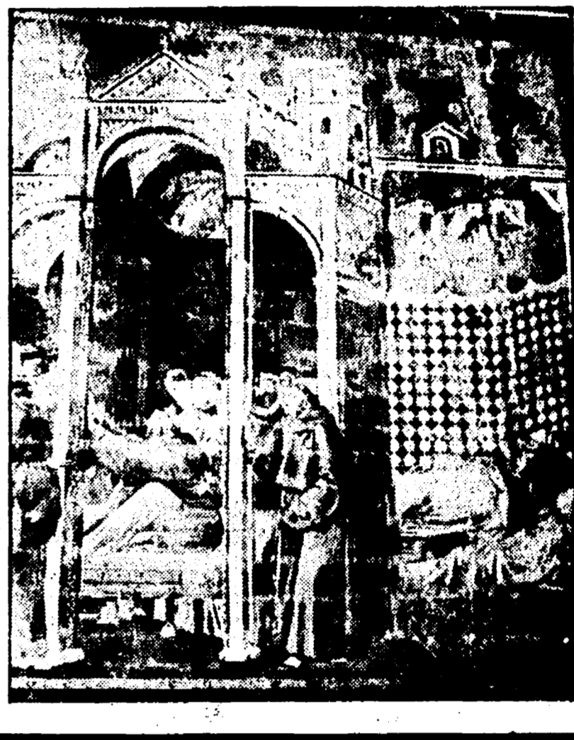
Nella foto a fianco un particolare dell'affresco dove si è aperta una lunga crepa del soffitto fino al pavimento.
