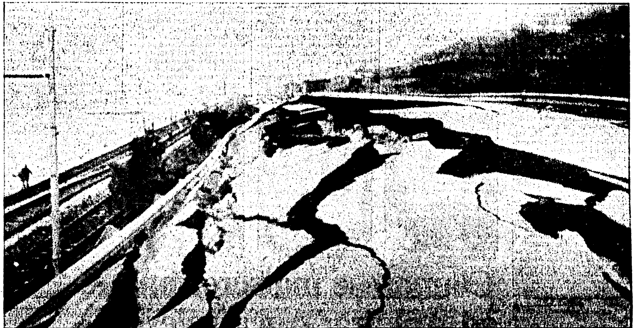
ANCONA — Le profonde voragini che hanno sconquassato la litoranea. Questo uno degli spaventosi effetti della frana che ha colpito la città
