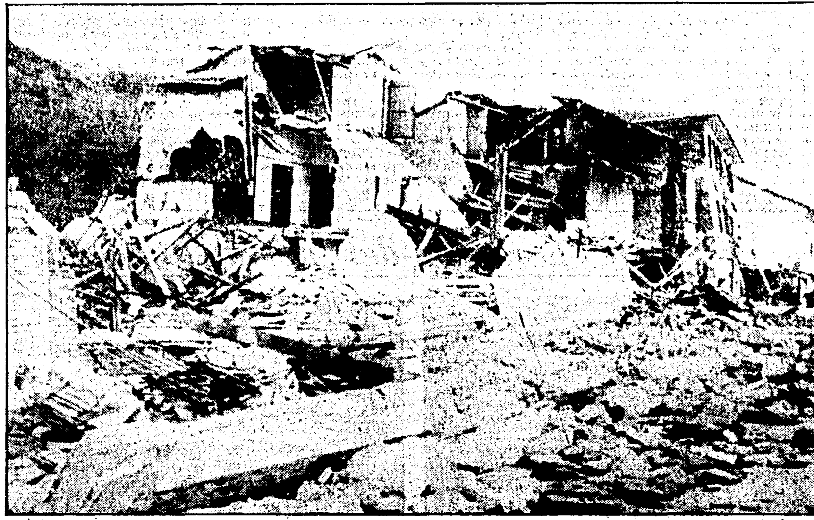
ANCONA — Le abitazioni distrutte nella zona Borghetto. Sopra al titolo i binari della linea Bologna-Foggia deformati dalla frana
