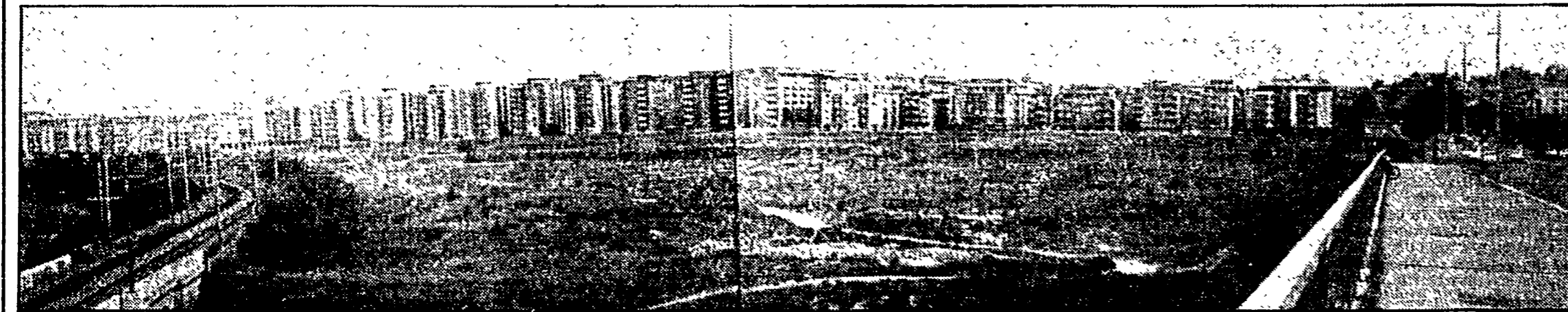
ROMA - Montecitorio. Una zona che si è sviluppata in modo abnorme negli ultimi decenni, si presenta così, con un muro compatto di cemento, a chi vi giunge dal centro.
