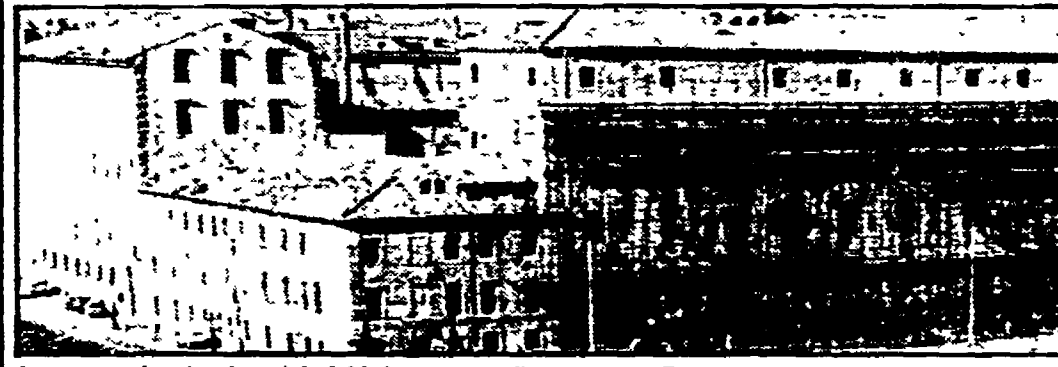
La sagoma lunghissima del «fabbricone» papalino, visto da Testaccio: l'intero perimetro dell'edificio è di circa un chilometro
