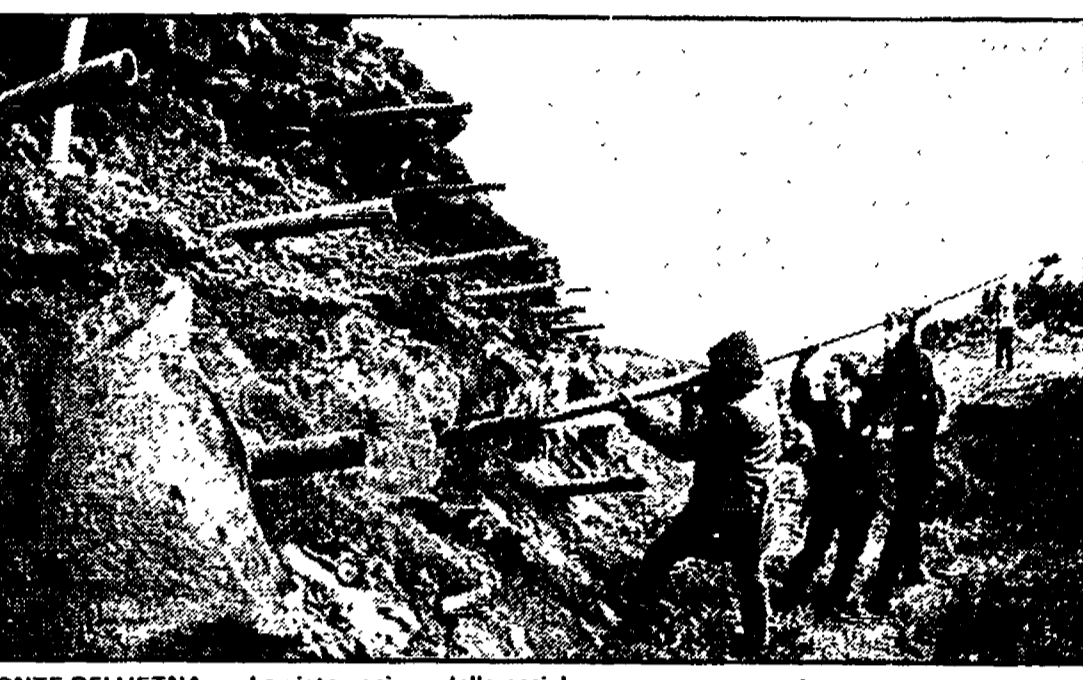
MONTE DELL'ETNA — La sistemazione delle cariche; una vera e propria gara contro il tempo
