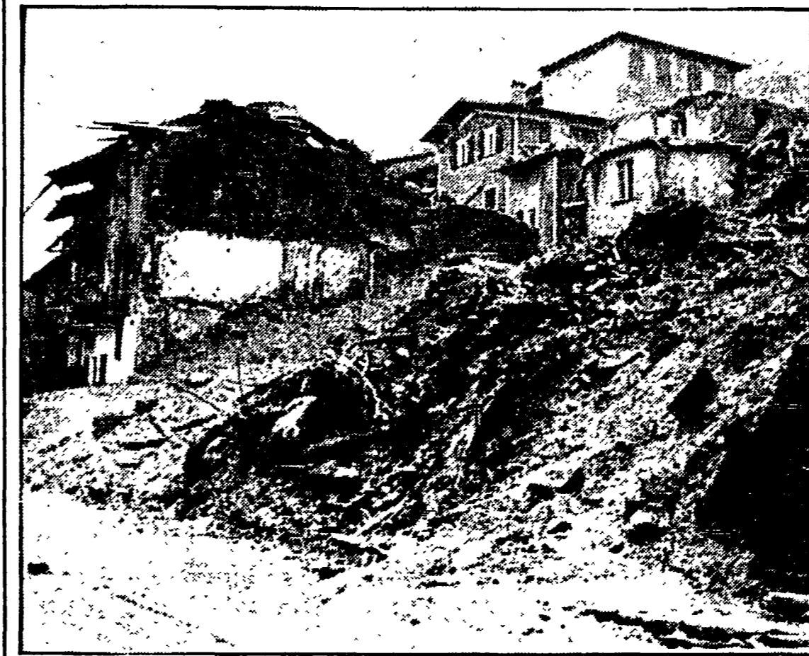
TRESENDA DI TEGLIO — Le case investite e distrutte dalla frana
