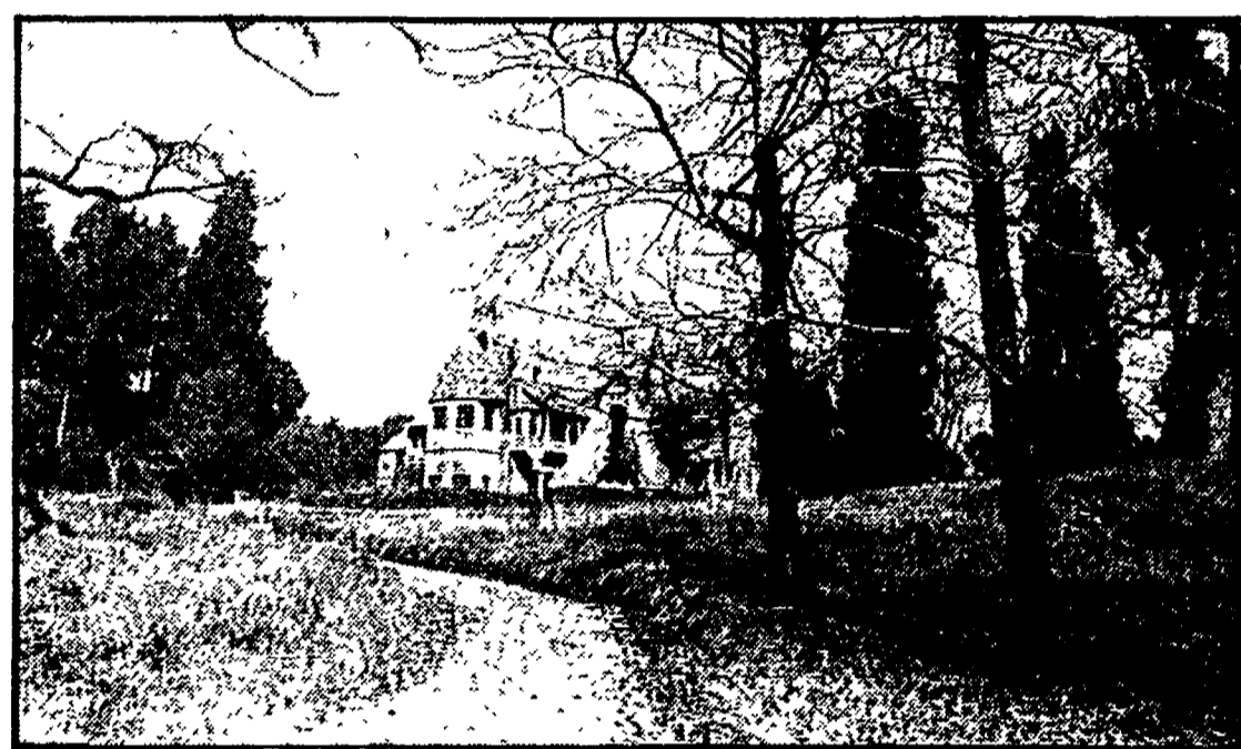
La casina delle civette a Villa Torlonia: dietro dovrebbe sorgere l'enorme cubo di cemento
