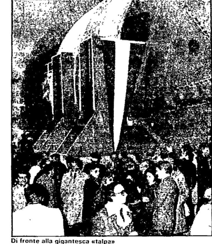
Di fronte alla gigantesca «talpa»
