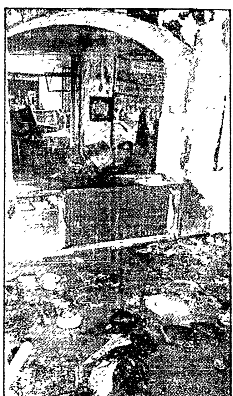
MILANO — L'interno del ristorante devastato dalle fiamme
