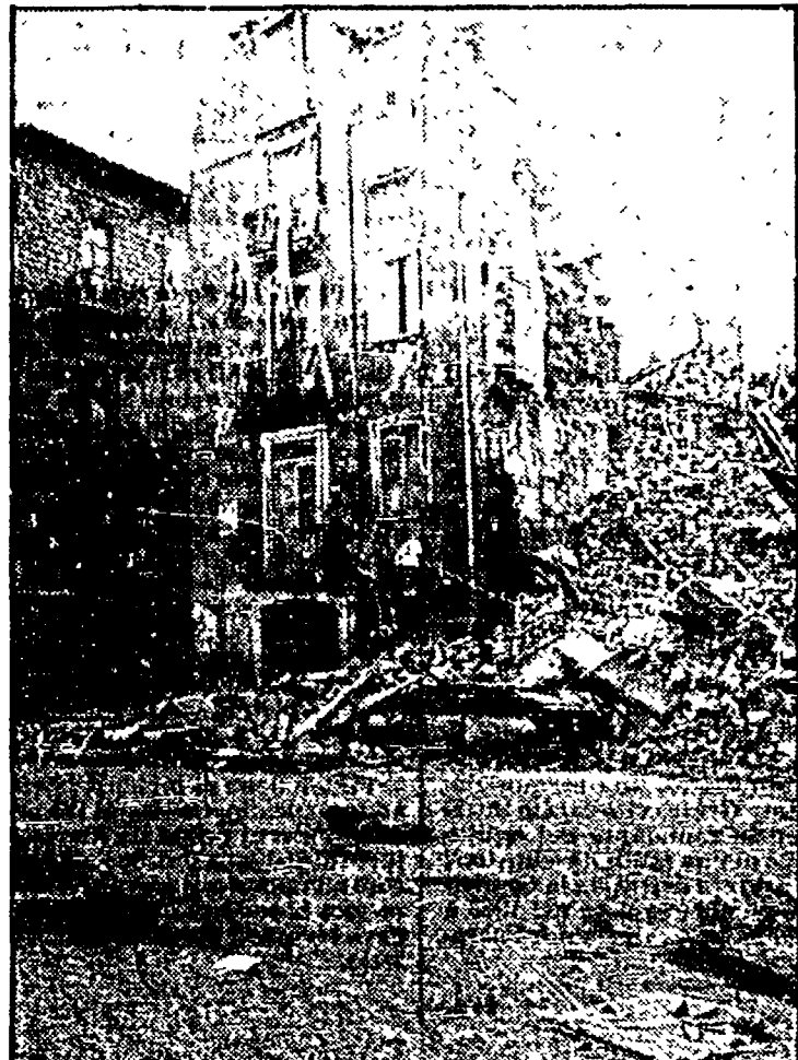
Un'immagine di Avellino dopo il terremoto del 1980: la clamorosa iniezione di questi giorni riguarda le case (mai finite di costruire) destinate ai senza-tetto
