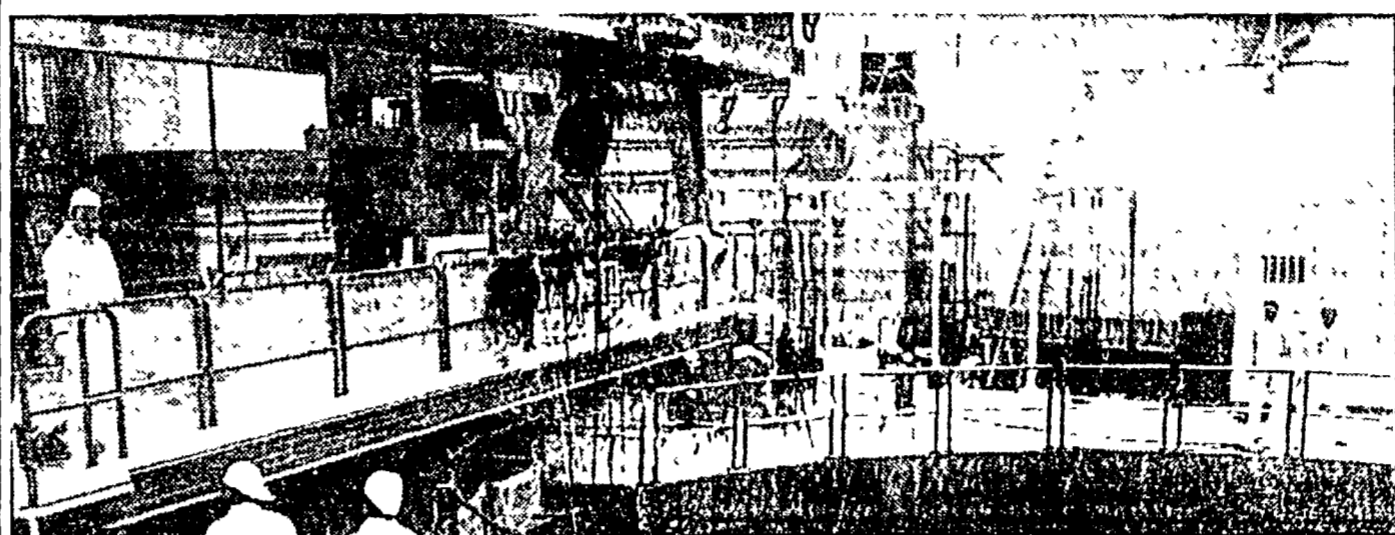
L'interno della centrale di Caorso
