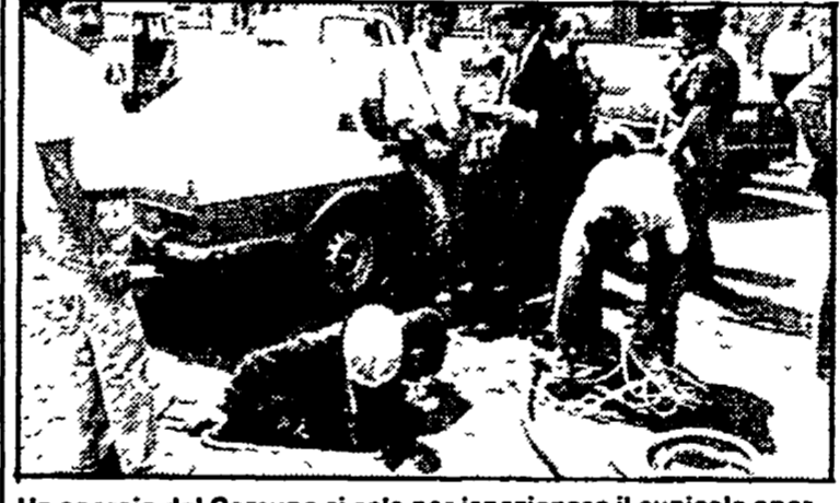
Un operaio del Comune si cala per ispezionare il cunicolo aperto dai ladri
